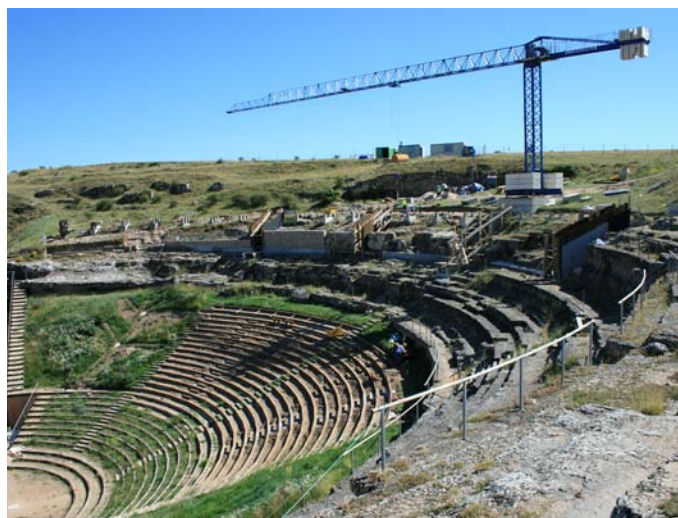
Restauració de la càvea superior del teatre romà de Clúnia.
