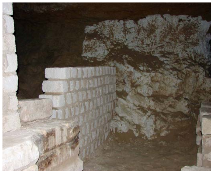
Treballs de consolidació de la galeria 2.
