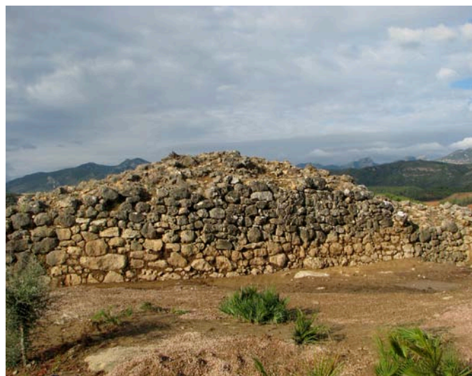
Vista final de la muralla, un cop excavat el nivell d'enderroc.
