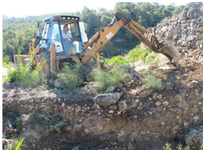
Excavació de l'enderroc de la muralla amb retroexcavadora.
