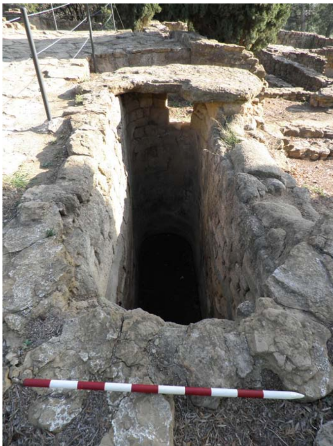
Cisterna 2 de Puig de Sant Andreu (Ullastret). Vista nord.
