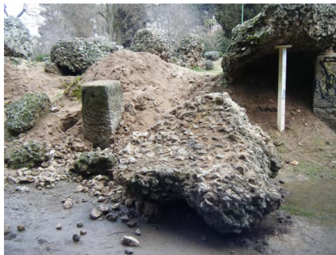
Circ romà de Toledo. Despreniments per les darreres pluges.
