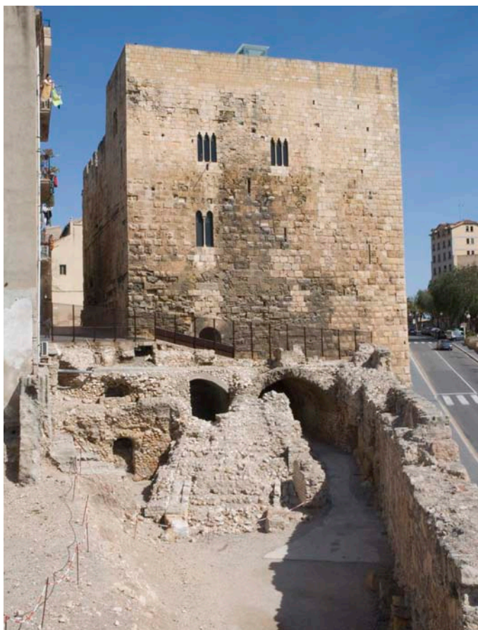
Detall de la façana meridional de la torre del Pretori.
