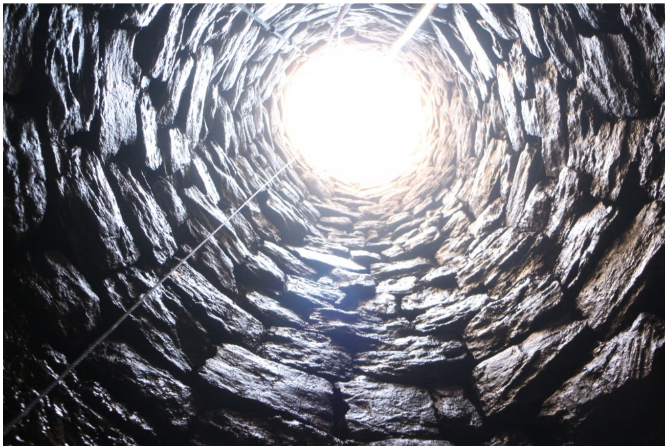
Vista de l'interior del pou (@ Equip Iesso)
