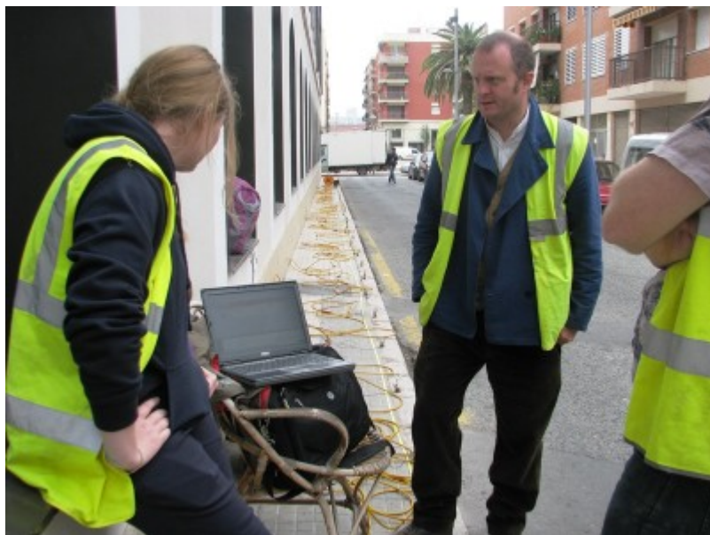
Prova de tomografia al carrer del Vapor.
