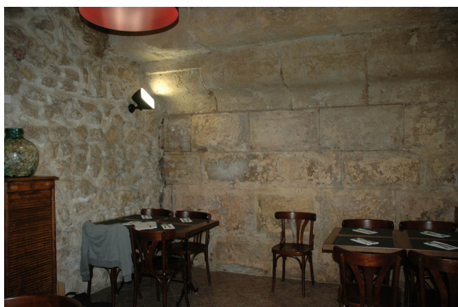
Detall del parament de la volta de carreus del recinte de culte (Restaurant el Gallo Morón)
